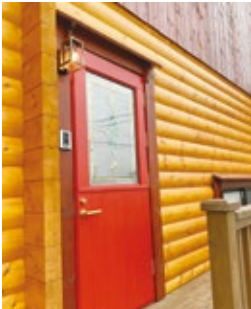
玄関ドアにはステンドグラス。
