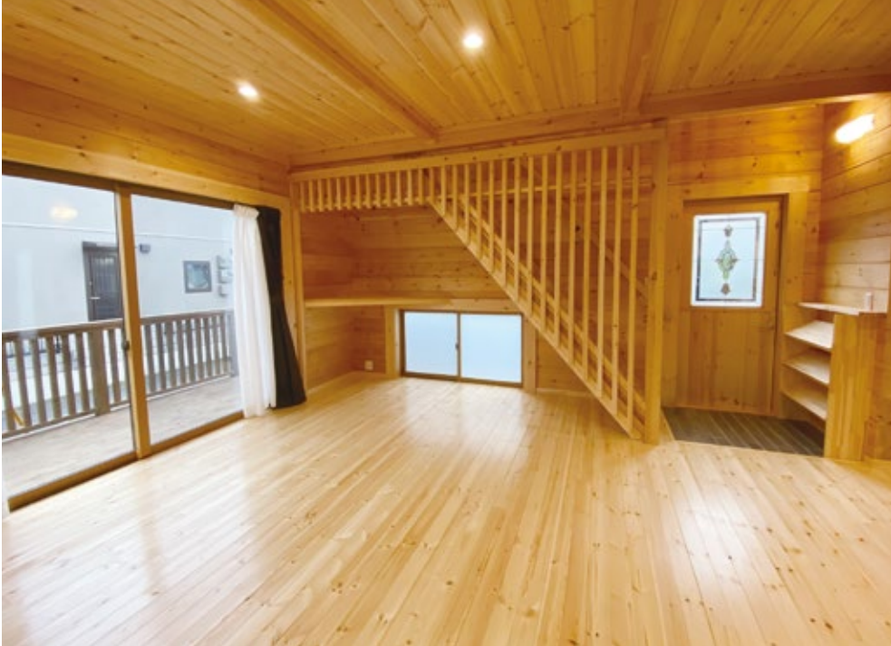
1階事務所と2階プライベートをつなぐ階段には縦格子の目隠しを設置した。
