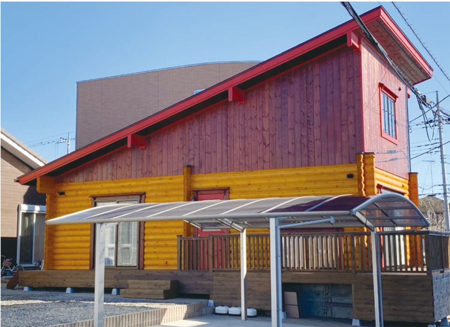
世間のイメージする山小屋に欠かせない切妻屋根をやめ片流れに。日差しを引き入れるため南側を高くした。
